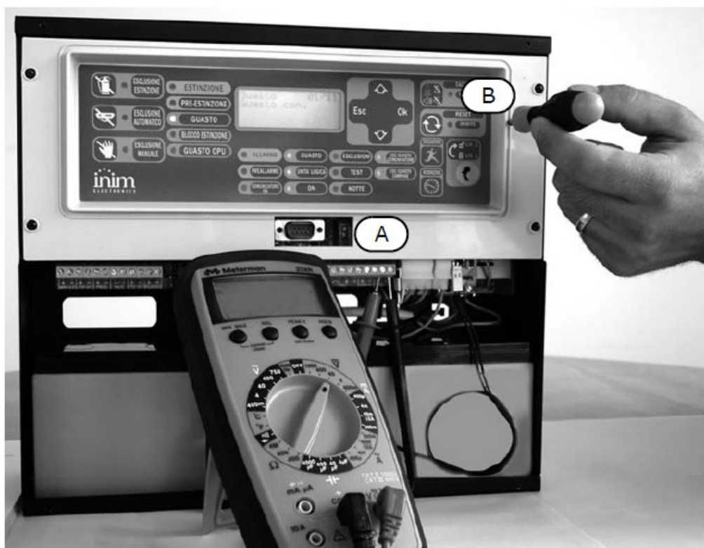
Rysunek 37 - Ustawianie napięcia ładowania akumulatorów
